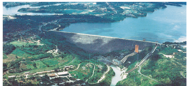
Karangkates Dam (Photo: Nippon Koei Co., Ltd.)
