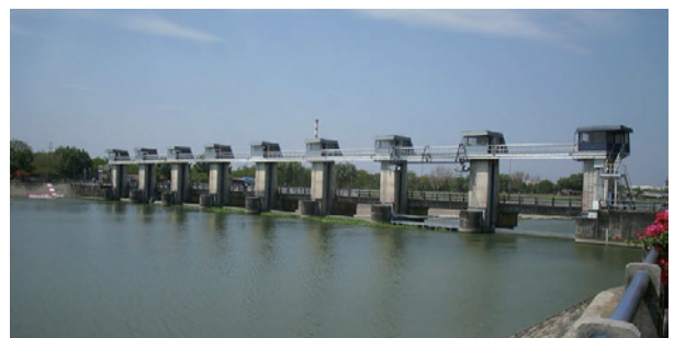
New Lengkong Barrage (Photo: Nippon Koei Co., Ltd.)
